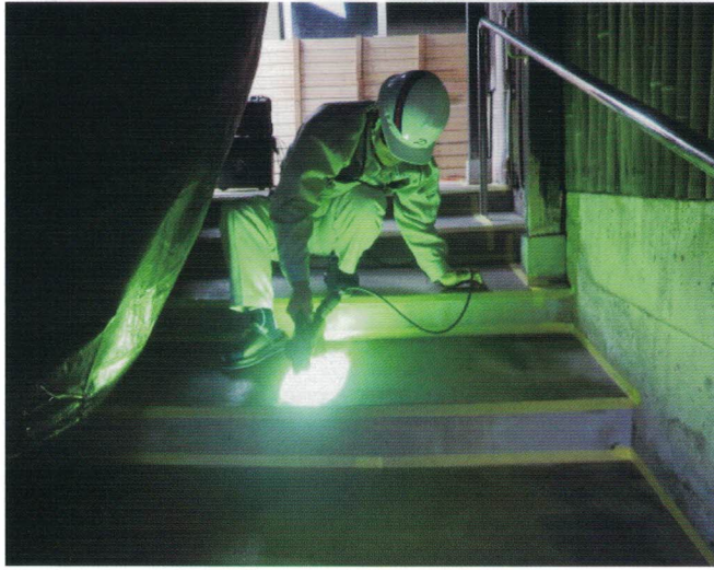
温泉での施工風景
