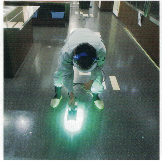
レストラン厨房での施工風景
