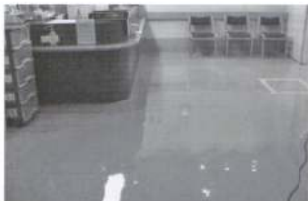
医療施設への施工例。防汚、防カビにも有効なため、サニテーションが要求される現場にも対応できる
