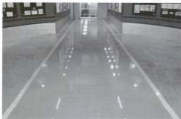
カラーリング施工により、中央の帯状の部分が鮮やかなグリーンに。動線を表示するのにも役立つ
