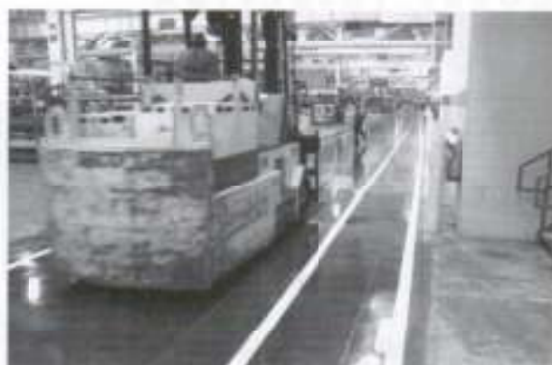
工場フロアへの施工例。薬品・熱・傷などにも強いうえ、フォークリフトを動かしても問題ない
