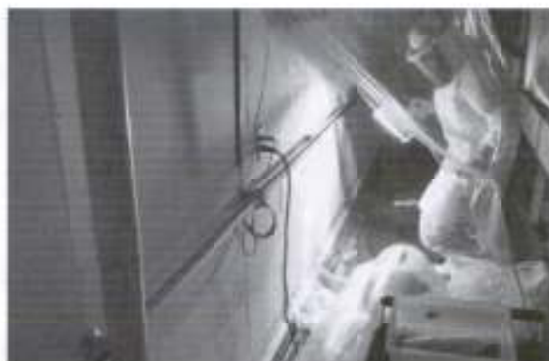
UV照射の様子。これまでかかっていた時間よりも大幅に短くなるため、店舗の営業を妨げずに施工できる
