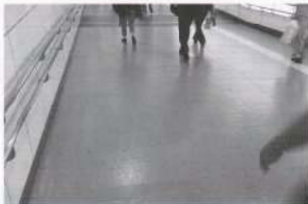
多くの人が行き交う駅の通路への施工例。「第三世代」は2年経っても美観を保ちつづけている
