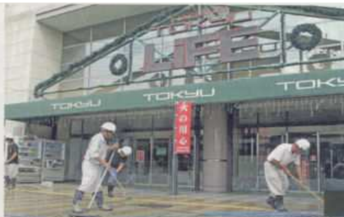
▲北長野ショッピングセンターながのの東急ライフ正面入口前での施工風景
