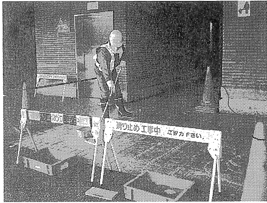
防滑工事の施工風景。タイルなどの床材を滑りにくくしている
